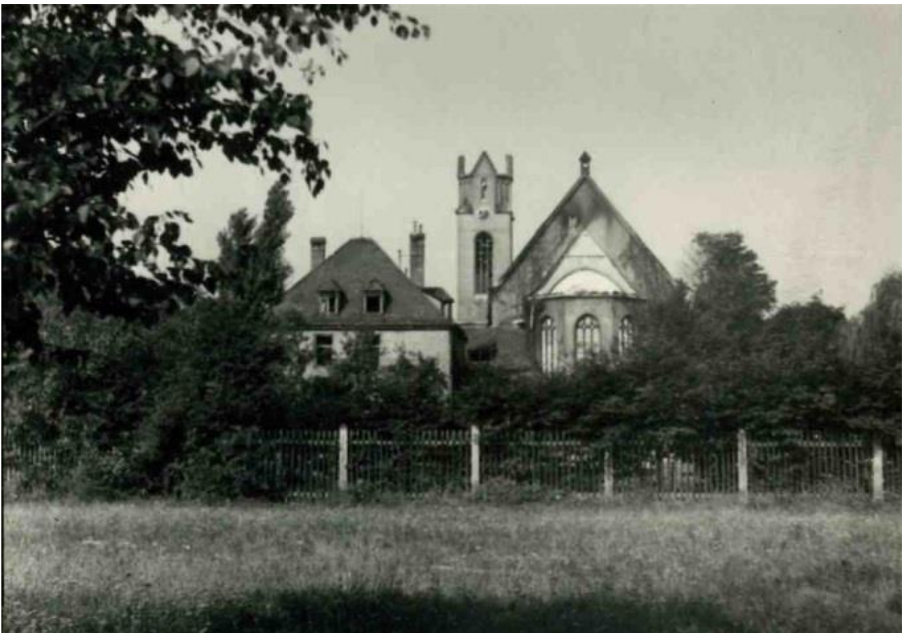
Eindrucksvolle Dokumente der Zerstörung.
